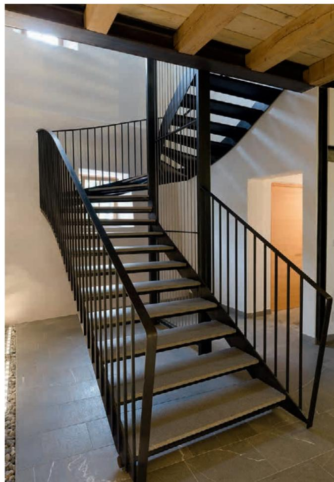
Im hinteren Bereich des Einhofes wurde eine neue, filigrane Stahltreppe zur Erschließung der Wohnungen im Ober- und Dachgeschoss errichtet, aus Schwarzstahl mit zartem Geländer und Trittstufen aus Naturstein.
