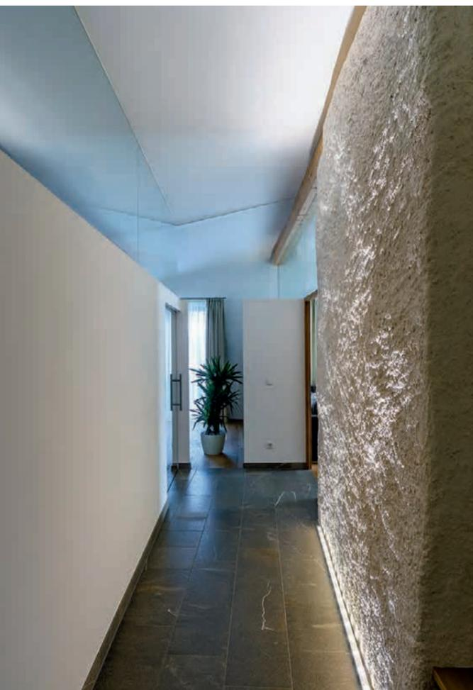
Die historischen Mauerscheiben des Stadels wurden mit ihren rauen Putzoberflächen erhalten; funktionsbedingt erforderliche Trennwände in Trockenbauweise mit glatter Putzoberfläche hinzugefügt.
